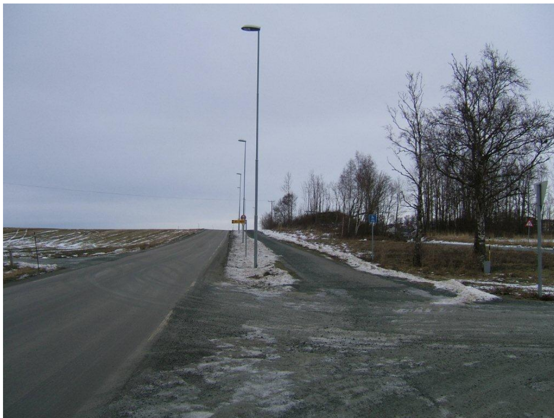
Julsborg – Eideskorsen, ny gang-/sykkelveg ferdigstilt i 2009
